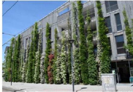
Abb. 24: Bodengebundene Fassadenbegrünung mit Kletterhilfen und Gerüstkletterpflanzen. Quelle: BuGG
