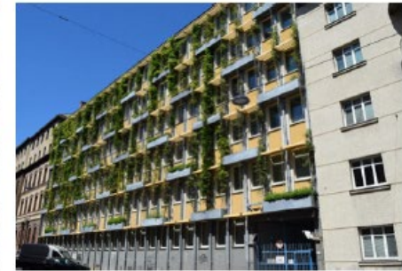
Abb. 28: Wandgebundene Fassadenbegrünung in horizontaler (Regal-)Bauweise. Quelle: BuGG
