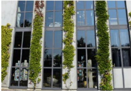
Abb. 23: Bodengebundene Fassadenbegrünung mit Selbstklimmern. Quelle: BuGG
